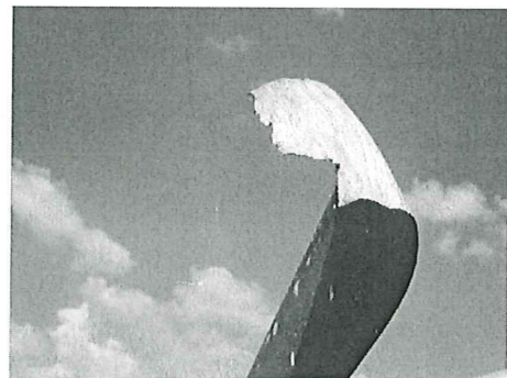
Daño en una de las palas de la hélice delantera
